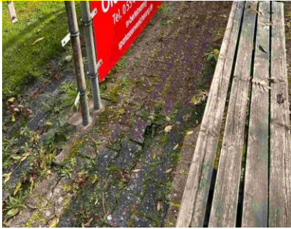
Tribüne A-Platz: Pflasterschäden
