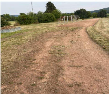
Leichtathletikanlage: Laufbahn mit Schadstellen (2020, 2023)
